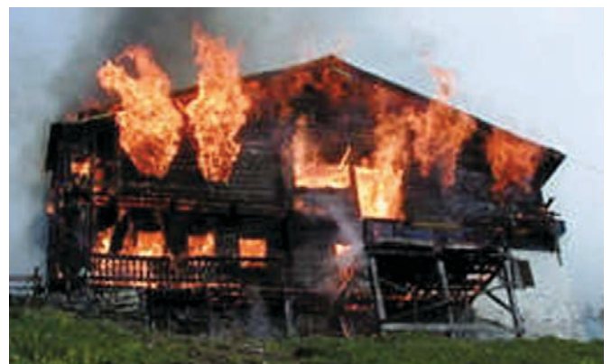
Abb. 32: Brandweiterleitung über die Fassade bei einem Bauernhaus in Holzbauweise
