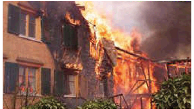
Abb. 29: Brand eines Zweifamilienhauses in Massivbauweise mit einem Anbau in Holzbauweise [17]
