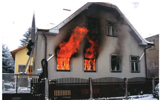
Abb. 30: Brandentwicklung an den Öffnungen bei einem Zimmerbrand in einem Massivhaus
